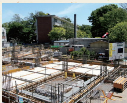
多目的棟建設現場
