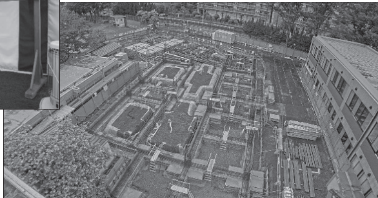
基礎工事 (2023年5月7日撮影)
